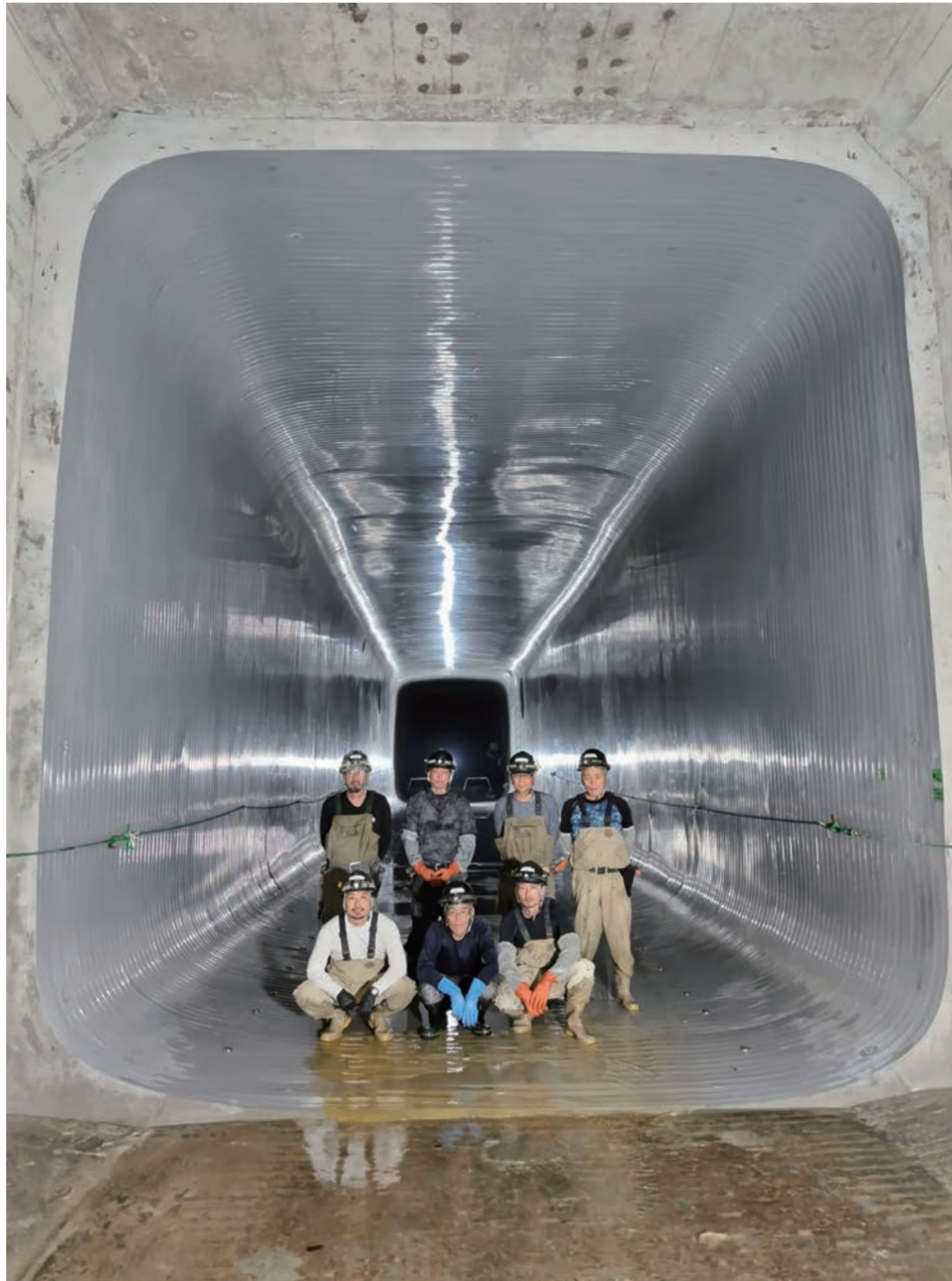
『大断面(矩形 5180mm×4730mm)更生管渠』 足立建設工業(株) 北岡 潤也 施工完了後やりおえた仲間と記念撮影。(板橋区桜川一丁目 田柄川幹線)
