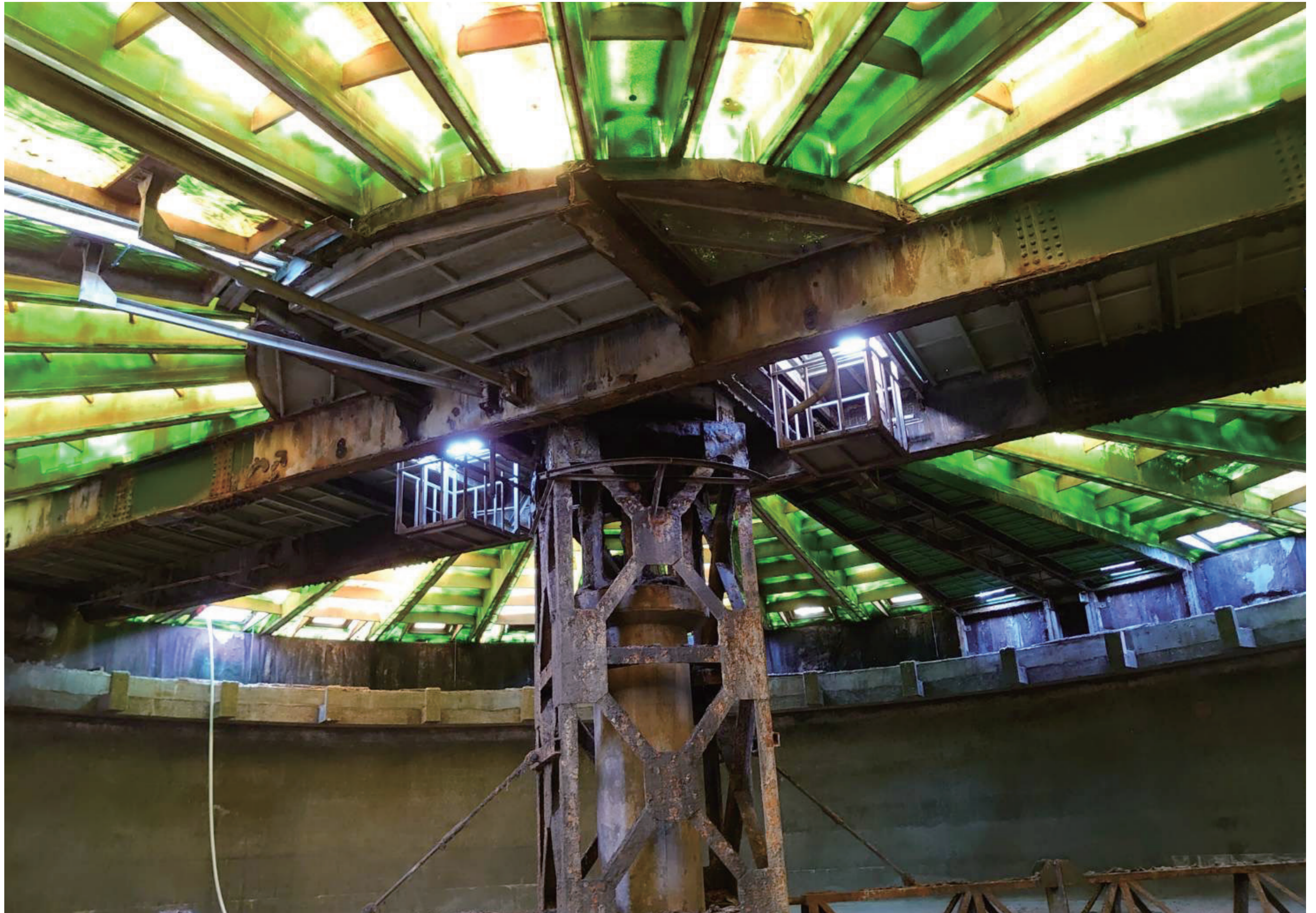
『重力濃縮槽(砂町水再生センターにて)』 光が映えてジブリ映画に出てきそうな雰囲気です。(砂町水再生センター 東部スラッジプラント) 泰伸工業(株) 渡辺 匠
