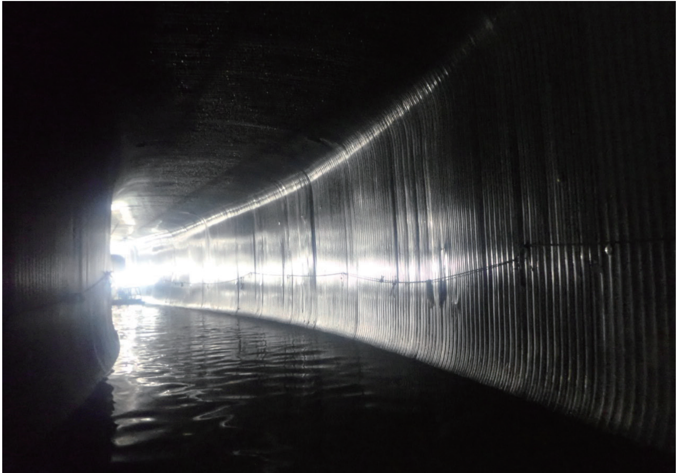
『大口径管きょ内』 更生された下水道の景色。(世田谷区豪徳寺一丁目)
