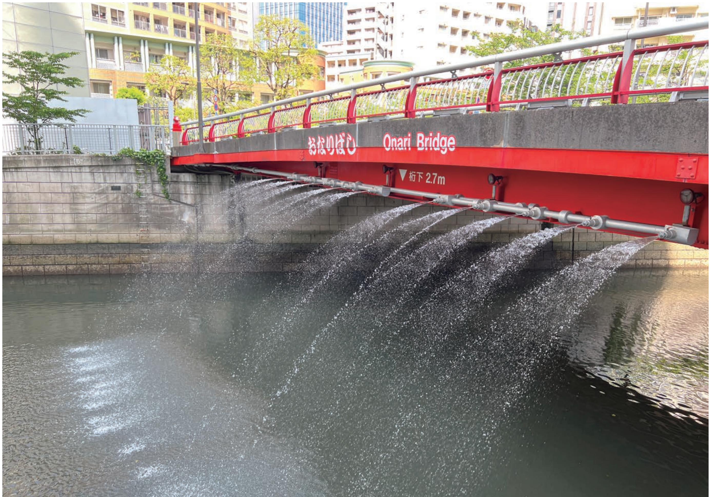
『再生水シャワーカーテン』 景観演出を目的として、芝浦水再生センターの再生水を御成橋から散水し、夜間はライトアップしています。 (品川区東五反田二丁目)
