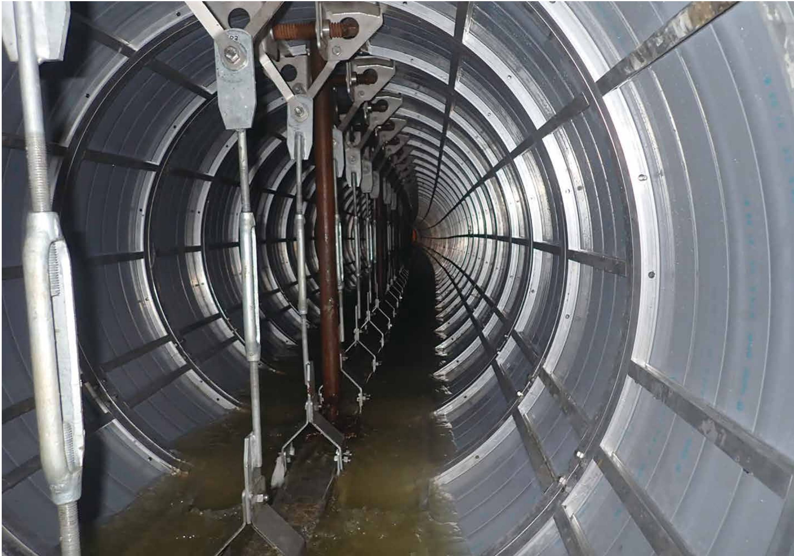
『内張り支保の景色』異世界へと繋がるような無機質な円形回廊が描く幾何学的な迷宮。(渋谷区富ヶ谷2丁目)
