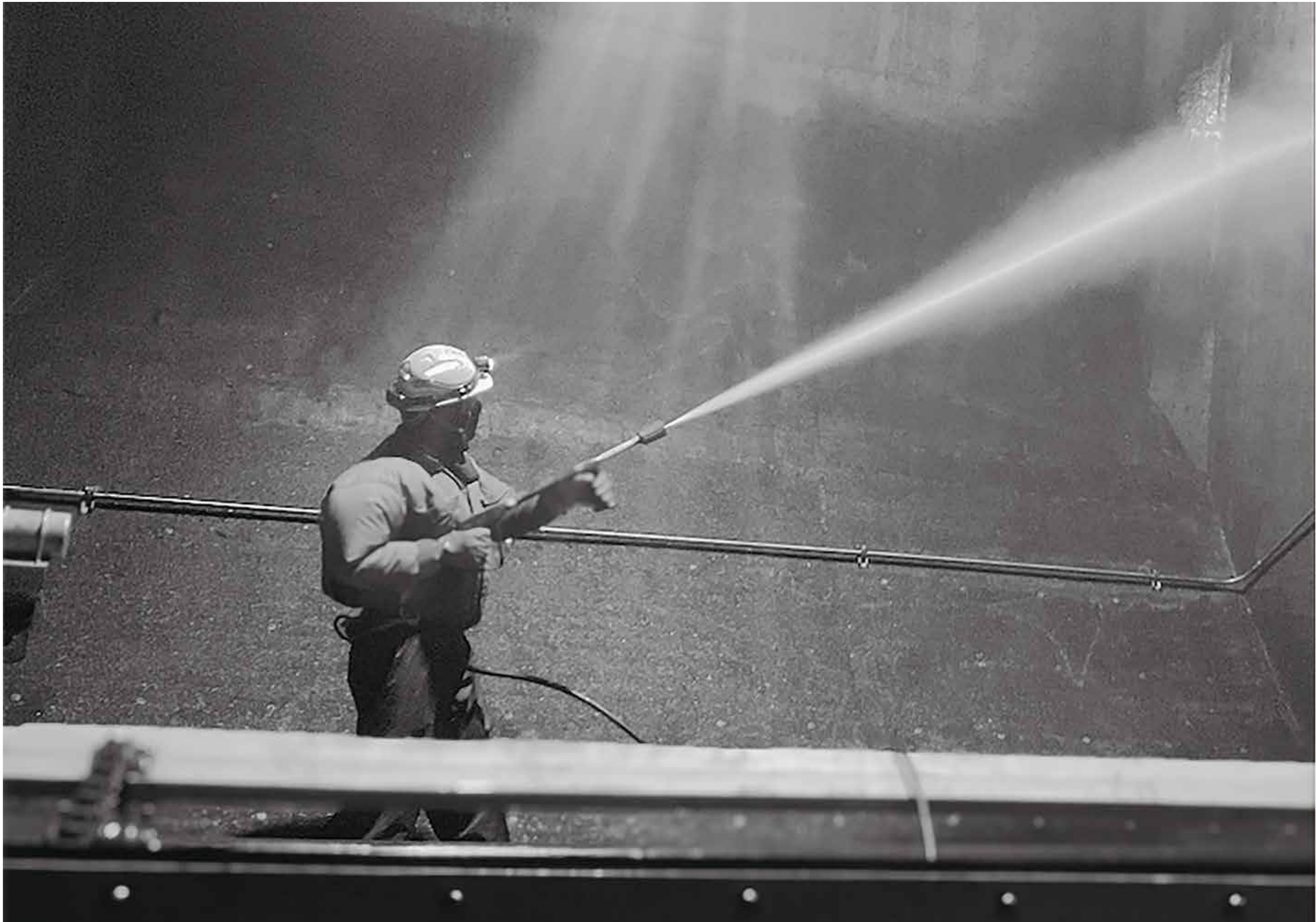
『見えない場所を守る人』洗浄している作業員を照らす光が綺麗でした。(水再生センター) 東信工業株式会社 川原 悠太
