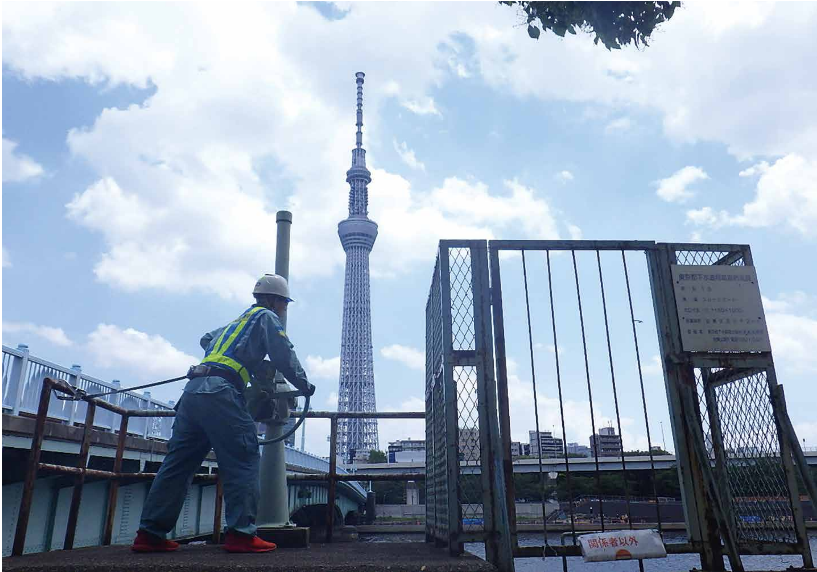
『東京スカイツリーに見守られ』高潮防潮扉点検作業中。下水道＝地下だけでなく、地上でも！（台東区花川戸2丁目） 加茂建設株式会社 仲永 千佳
