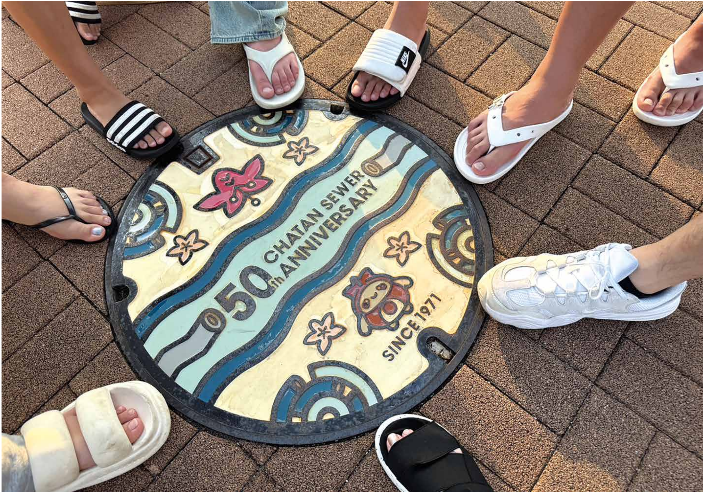
『可愛いマンホールみつけ♪』北谷下水道50周年記念マンホール！旅行中でもマンホールに目がいきます。(沖縄県中頭郡北谷町字美浜54) 尾島興業株式会社 尾島 由雅
