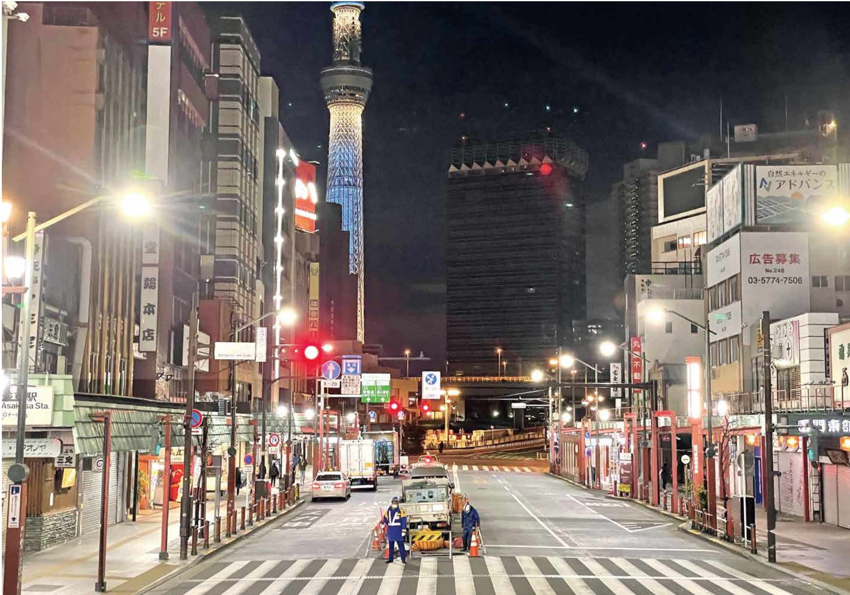
『寝静まった下町』寒い中の管路内清掃作業、輝くスカイツリーが応援してくれてました。(台東区浅草2丁目雷門前) 正和興業株式会社 樫村 克哉
