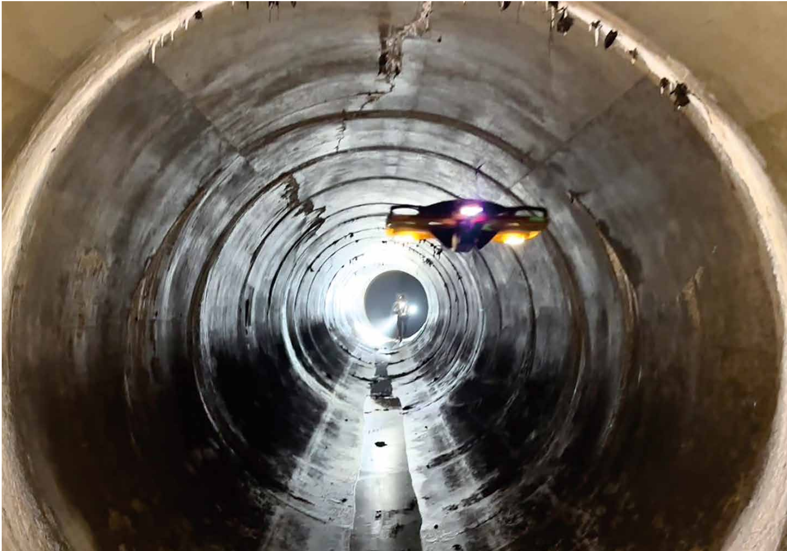
『ドローンの下水道探検』人が立ち入るのが困難な箇所を想定した調査の様子です。(中野区江古田公園)
