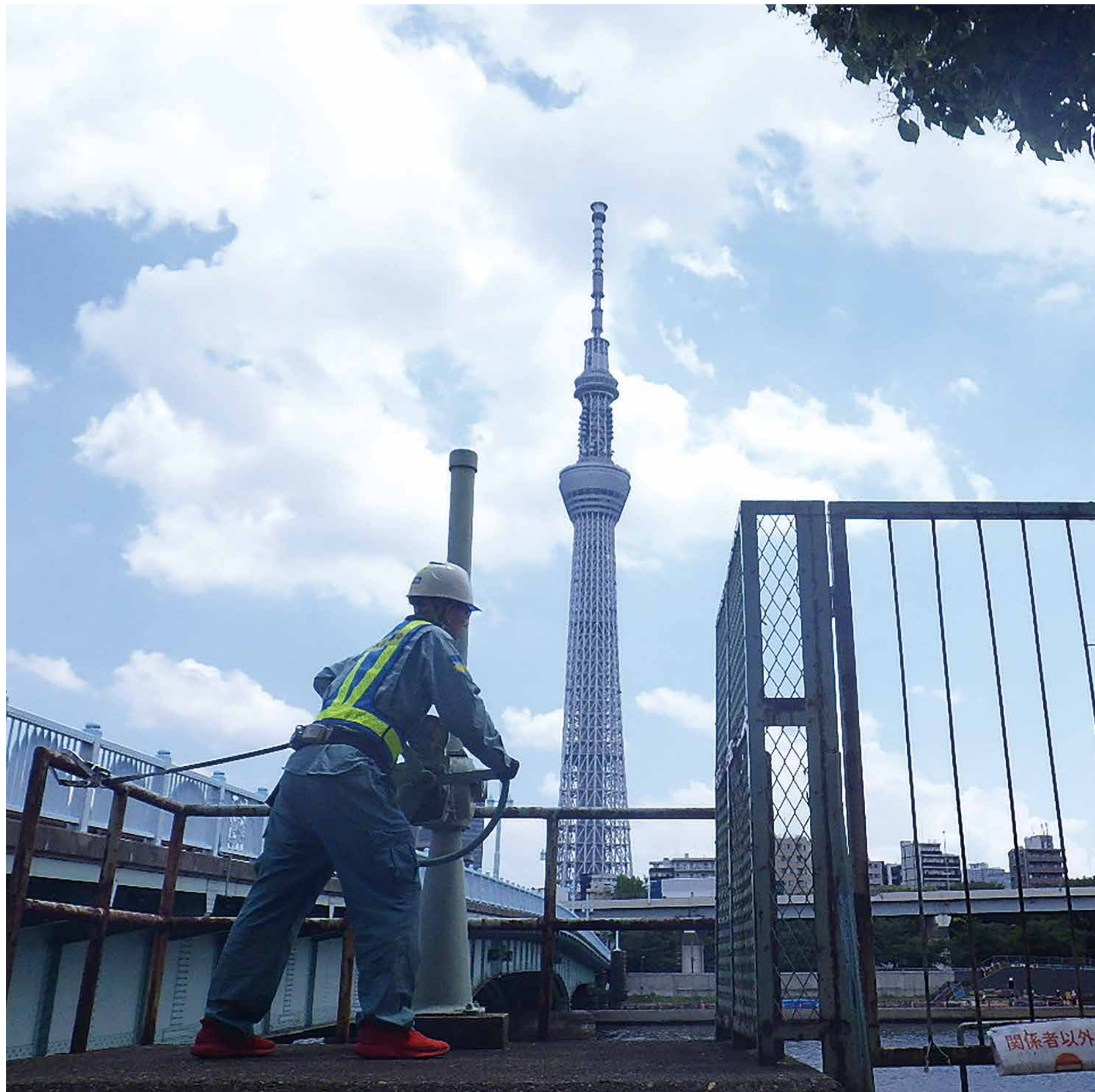
『東京スカイツリーに見守られ』高潮防潮扉点検作業中。下水道＝地下だけでなく、地上でも！ (台東区花川戸2丁目) 加茂建設株式会社 仲永 千佳
