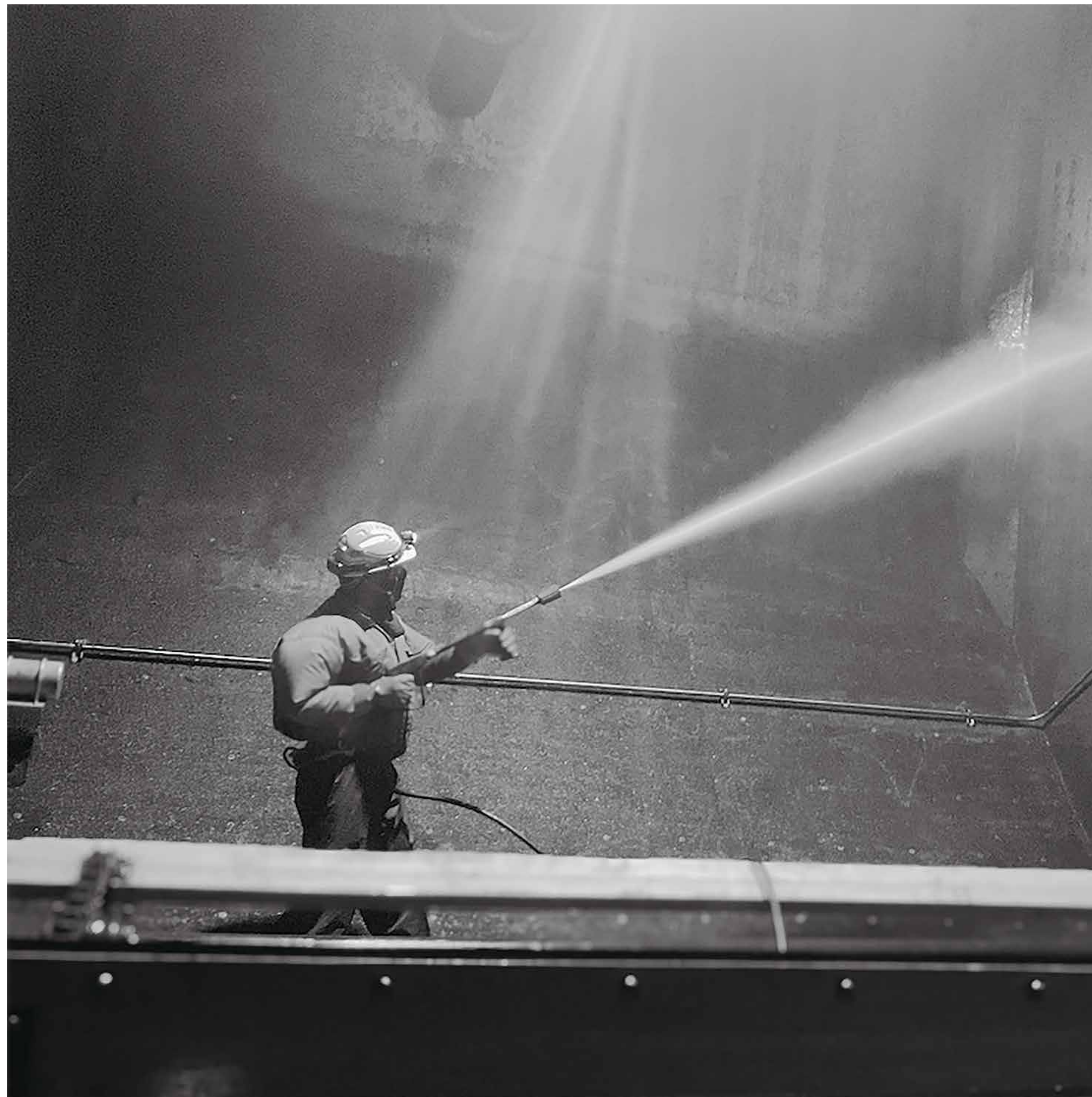
『 見えない場所を守る人 』 洗浄している作業員を照らす光が綺麗でした。 (水再生センター) 東信工業株式会社 川原 悠太
