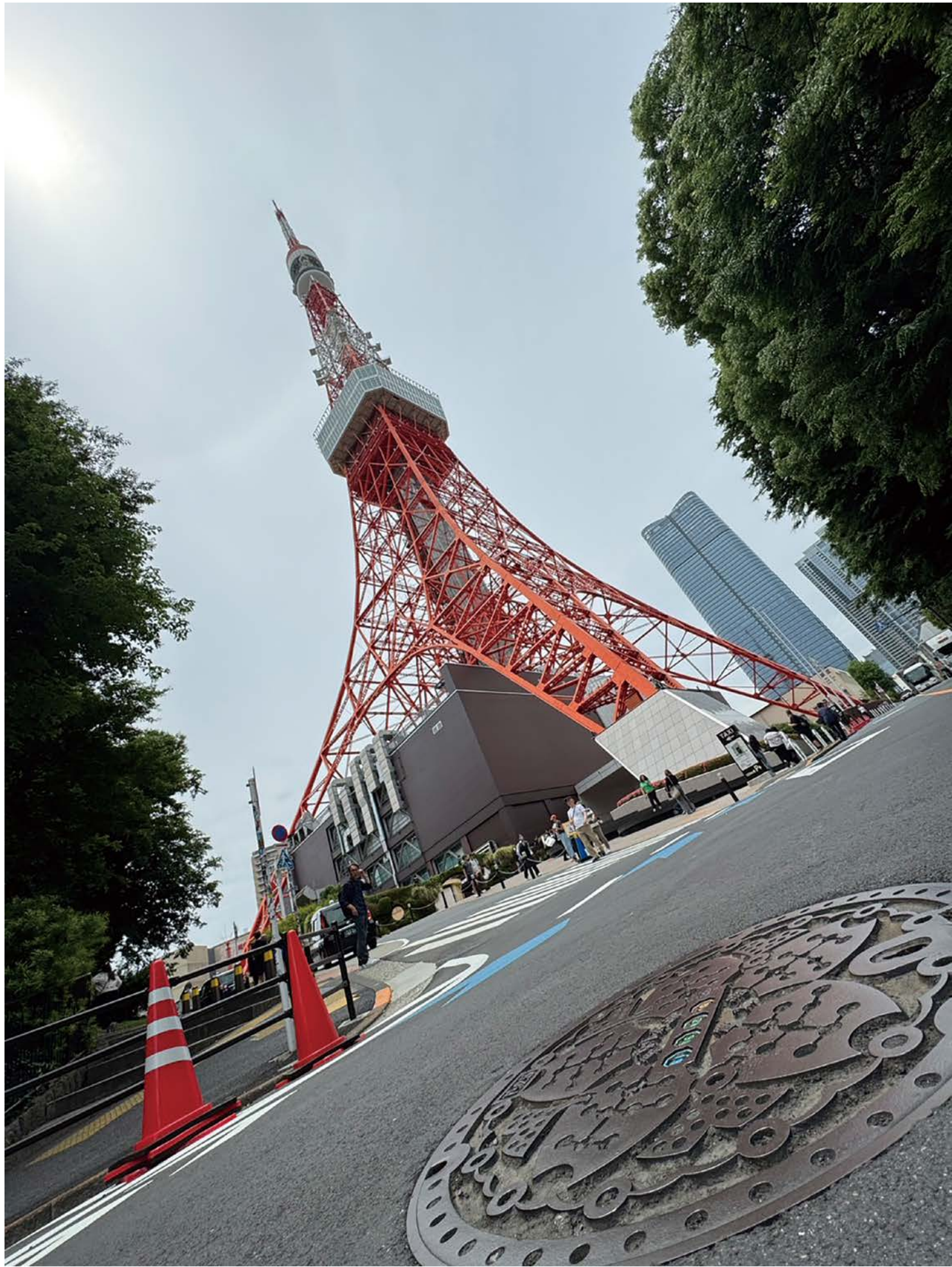
『日本電波塔を見上げる人孔』 近くの現場を下見中に激写。 (港区芝公園4丁目)
