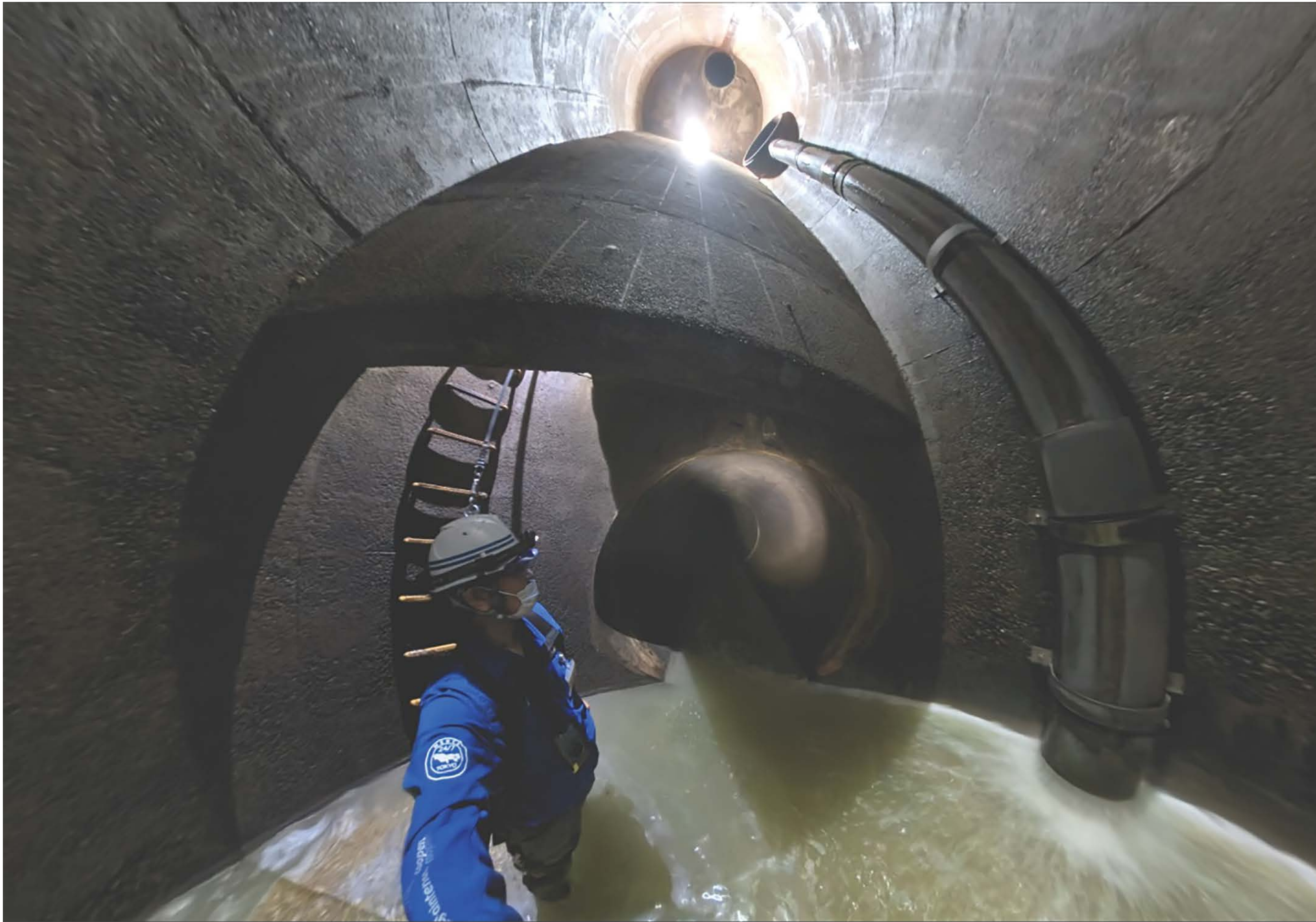
『360度カメラでマンホール内を撮影してみた』パノラマカメラだとマンホール内の構造がわかりやすい。(練馬区 旭町幹線) 管清工業㈱ 藤田 修
