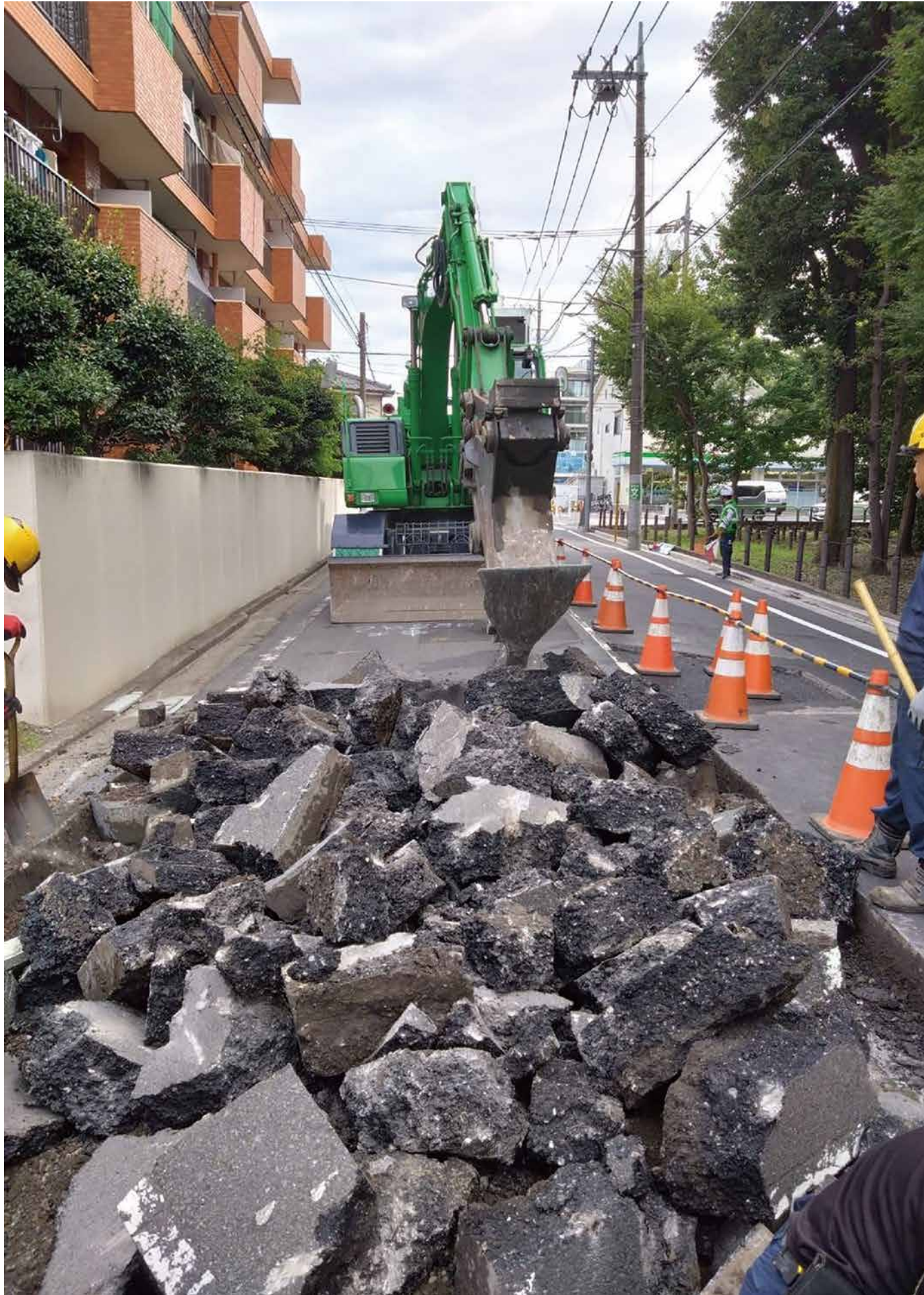
『バリバリ壊します！』舗装壊し中。(練馬区羽沢) 松戸建設㈱ 渡辺 海士
