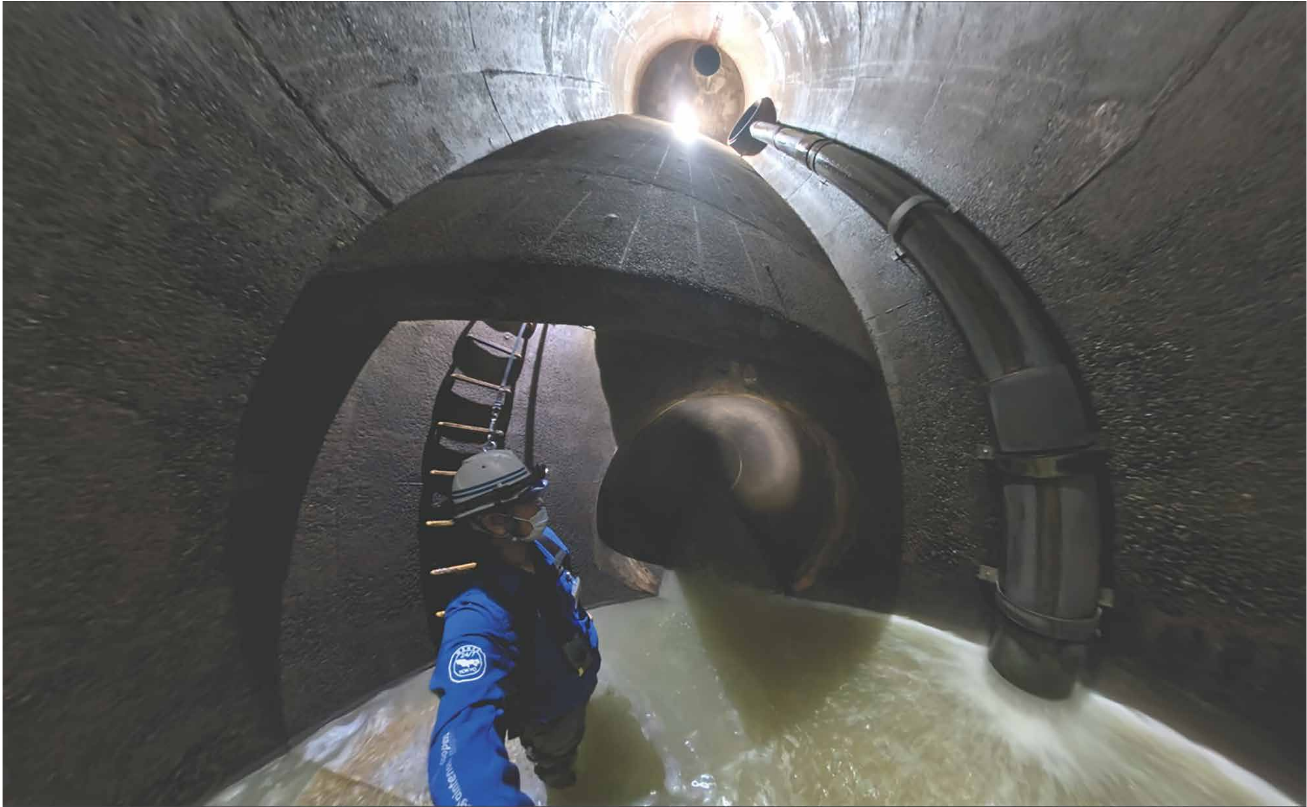
『360度カメラでマンホール内を撮影してみた』 パノラマカメラだとマンホール内の構造がわかりやすい。(練馬区 旭町幹線) 管清工業㈱ 藤田 修
