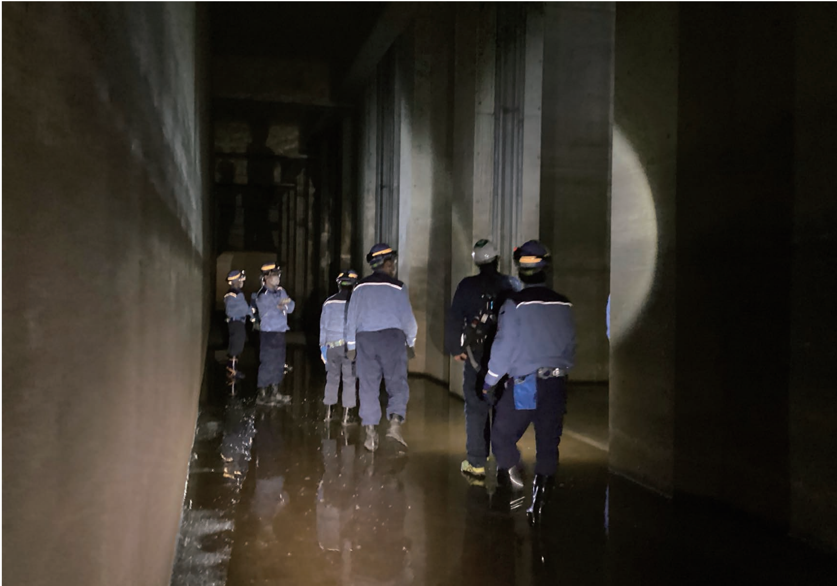
『放流渠の探検』 普段人が入れない放流渠に行きました。(神谷ポンプ所放流渠雨水ポンプ吐出し口付近)
