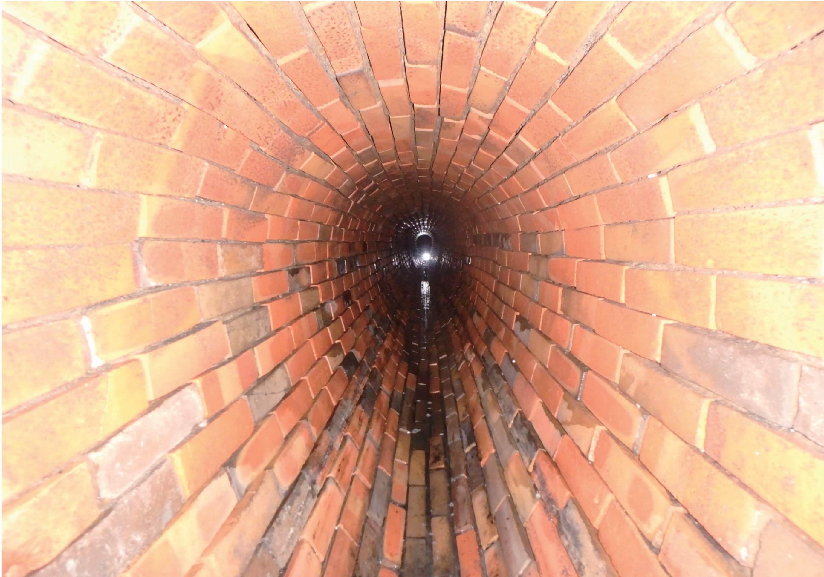
『 30 年のキャリアで初めての出会い 』 レンガ造りの卵形下水道管。下水道の歴史に触れました。(台東区浅草一丁目) 新栄工業(株) 澤谷 晃司
