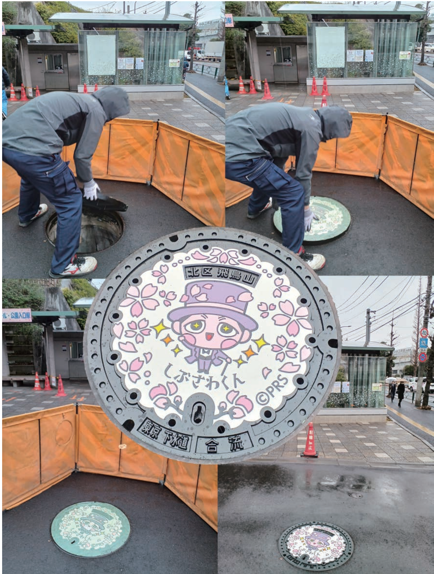
『しづさわくんマンホール蓋設置作業』 新1万円札にデザインされた渋沢栄一翁のキャラクター「しづさわくん」のマンホールを設置しました。 (区立飛鳥山公園「アスカルゴ」乗場前)
