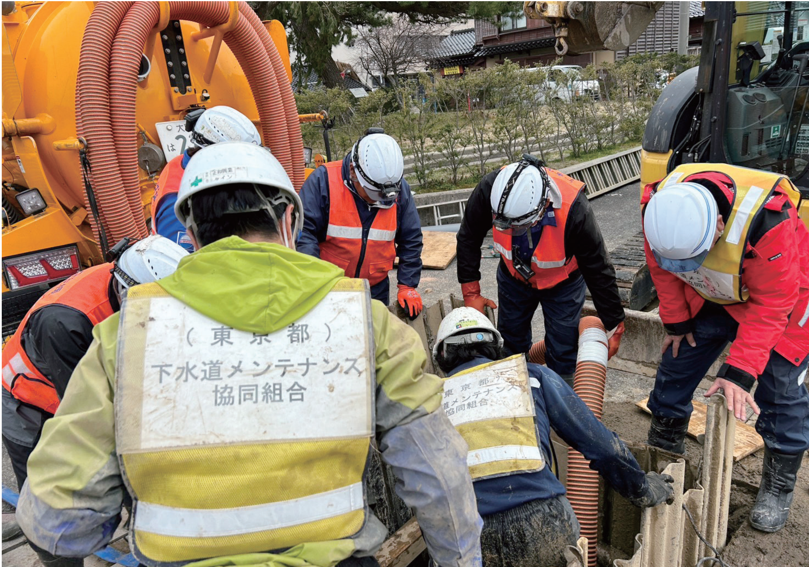
『能登半島地震被災復旧支援！(土木と管掃チームの協力)』 土木班掘削中、地下水位の高い掘削困難箇所にて、管掃班がバキュームで応援し、無事に補修ができました。(石川県輪島市) 正和興業(株) 井上 祐樹
