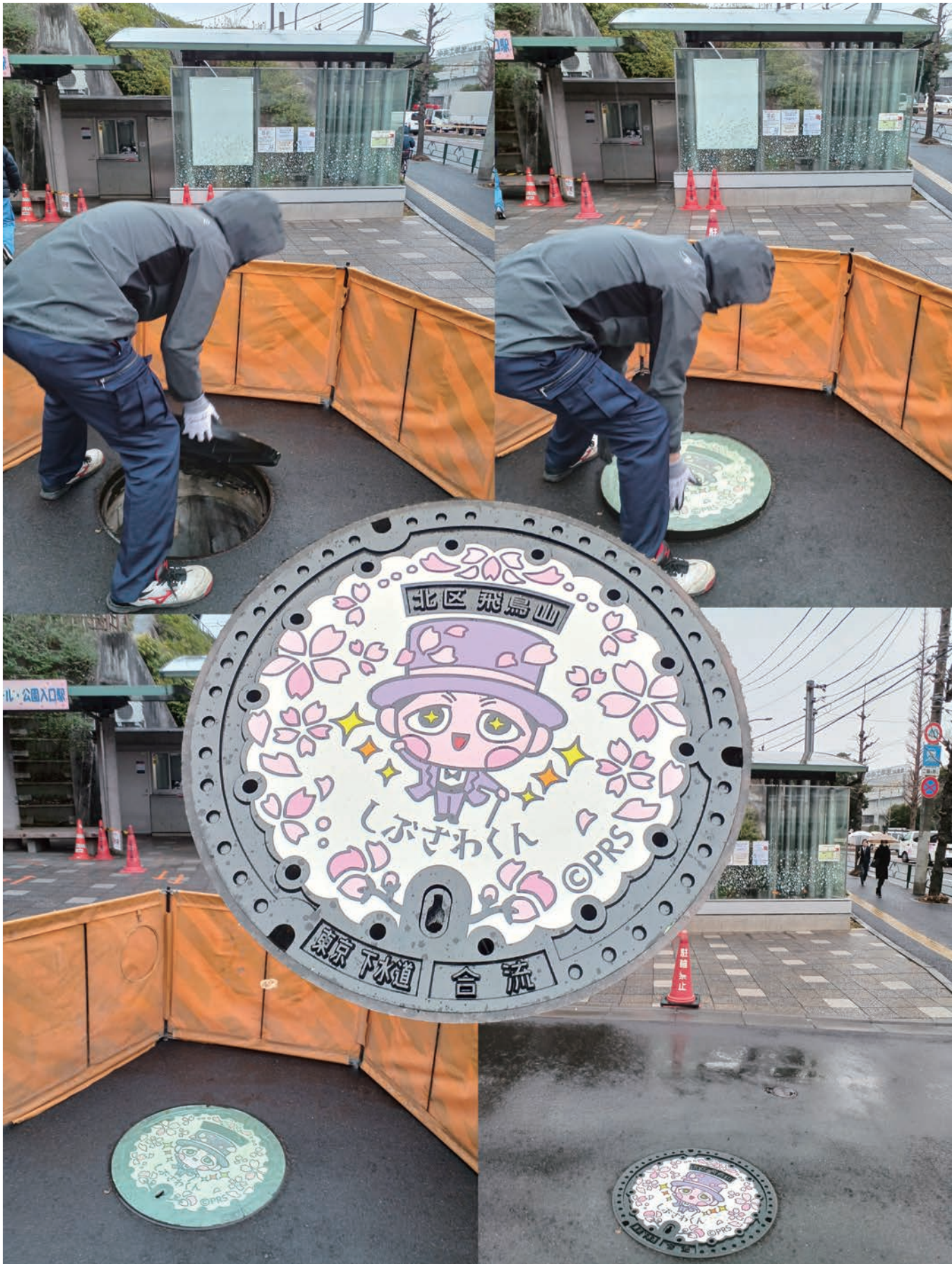
『しゅさわくんマンホール蓋設置作業』 新1万円札にデザインされた渋沢栄一翁のキャラクター「しゅさわくん」 のマンホールを設置しました。(区立飛鳥山公園「アスカルゴ」乗場前) 松村土建工業(株) 松村 康正
