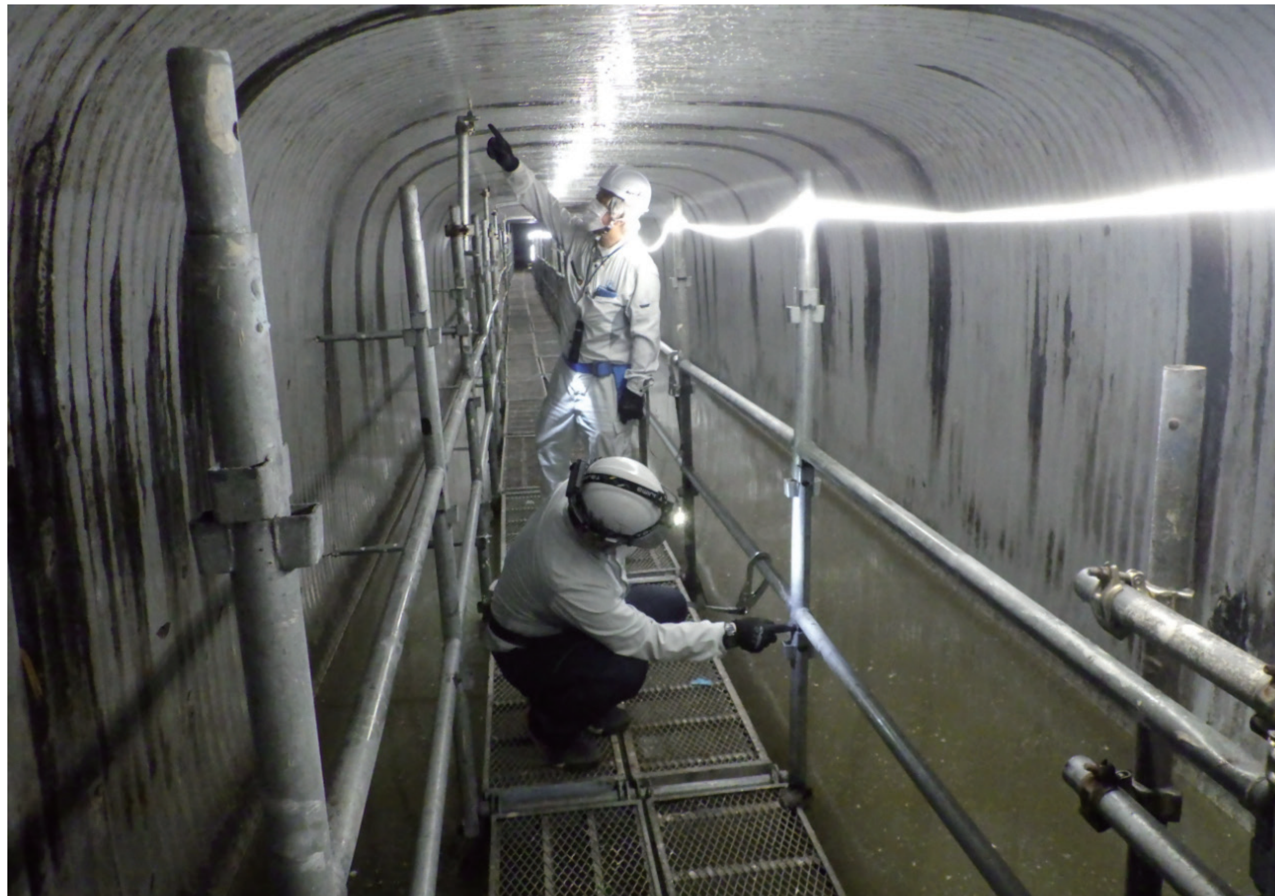
『幹線内足場写真』 推進管取付箇所の足場点検作業中に撮影しました。足場点検ヨシ！（中央区築地七丁目） 大峰建設(株) 奥井 紀匡
