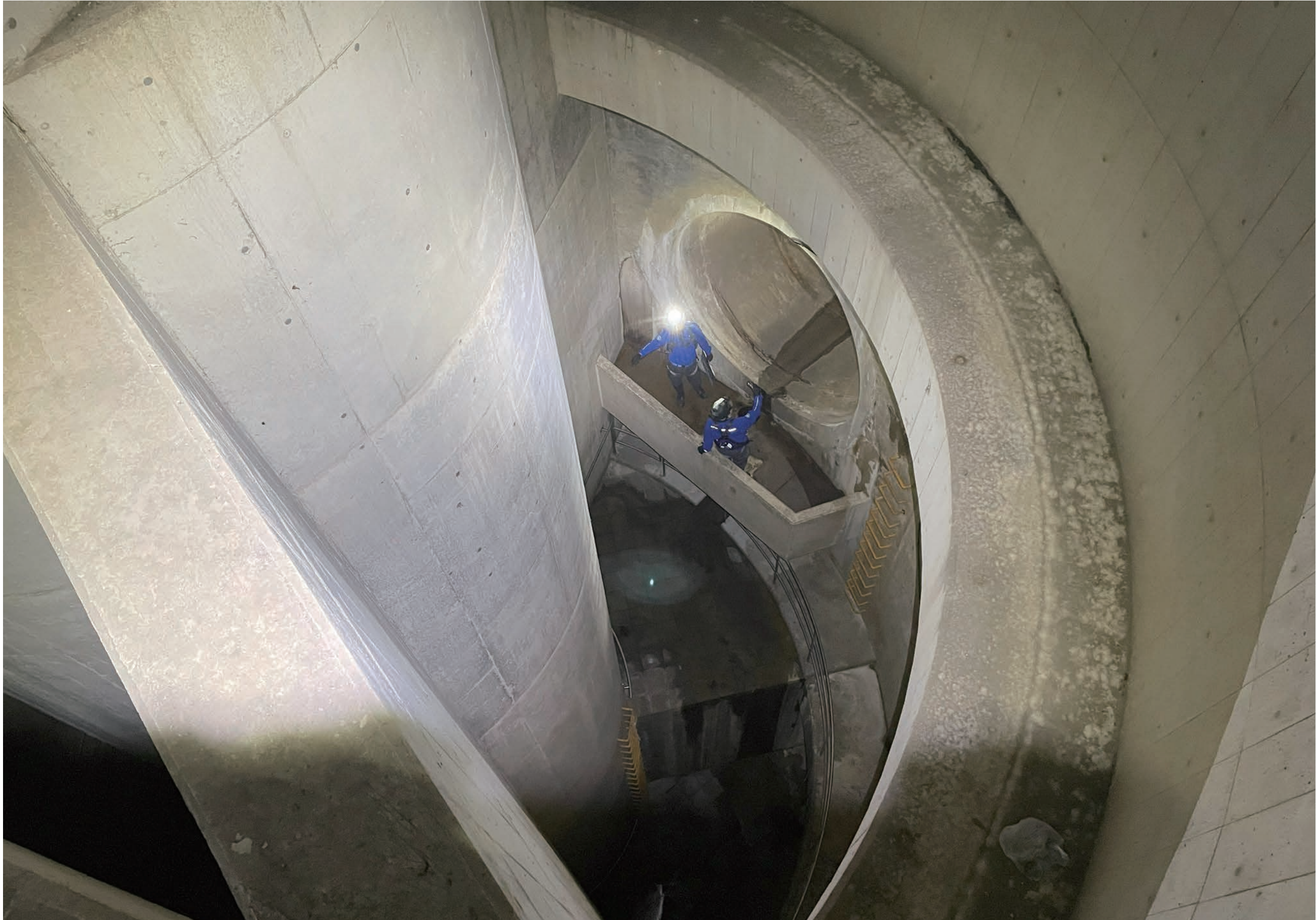
『巨大人孔』 深さ 50 メートルもある巨大人孔、人の目で点検します。(千代田区一番町) 動栄工業(株) 千田 龍也
