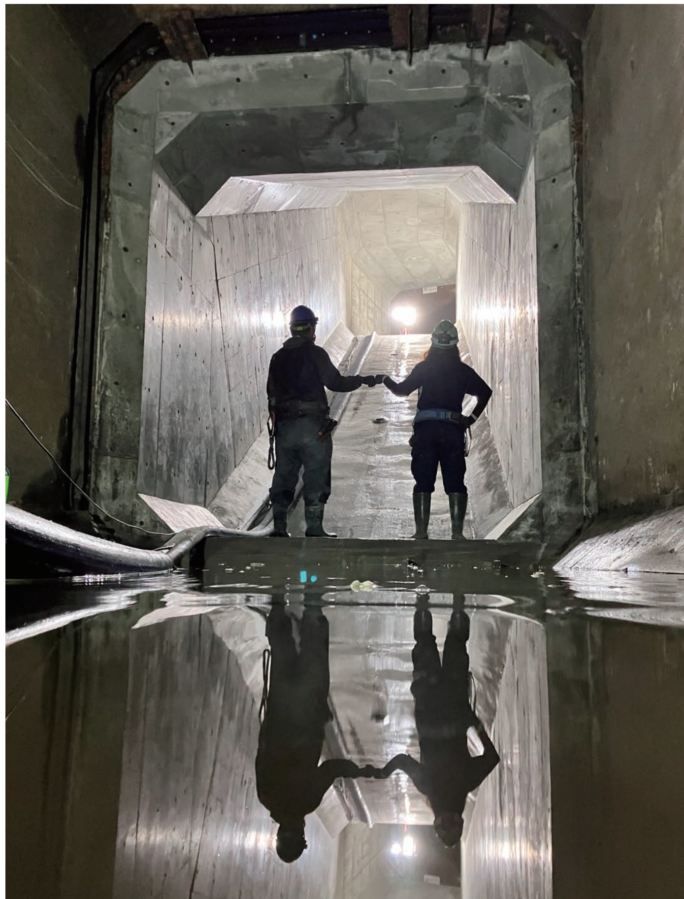
『 竣工の瞬間(とき) 』 新米社員の初現場・初竣工。お世話になった職長さんとグータッチ !! (東金町ポンプ所放流渠内) 東信工業(株) 丸目 周平
