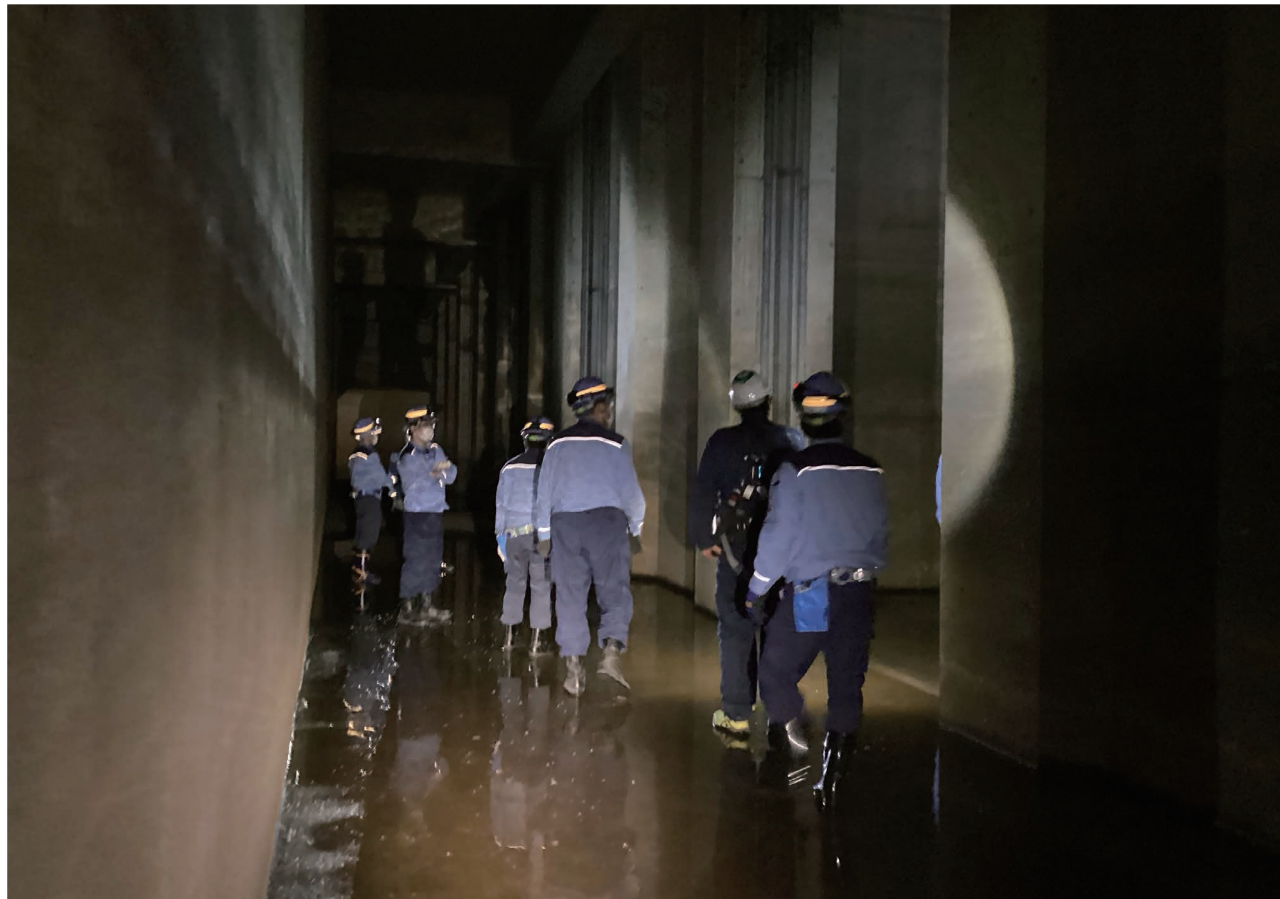
『放流渠の探検』 普段人が入れない放流渠に行きました。(神谷ポンプ所放流渠雨水ポンプ吐出し口付近) 東信工業(株) 益山 功作
