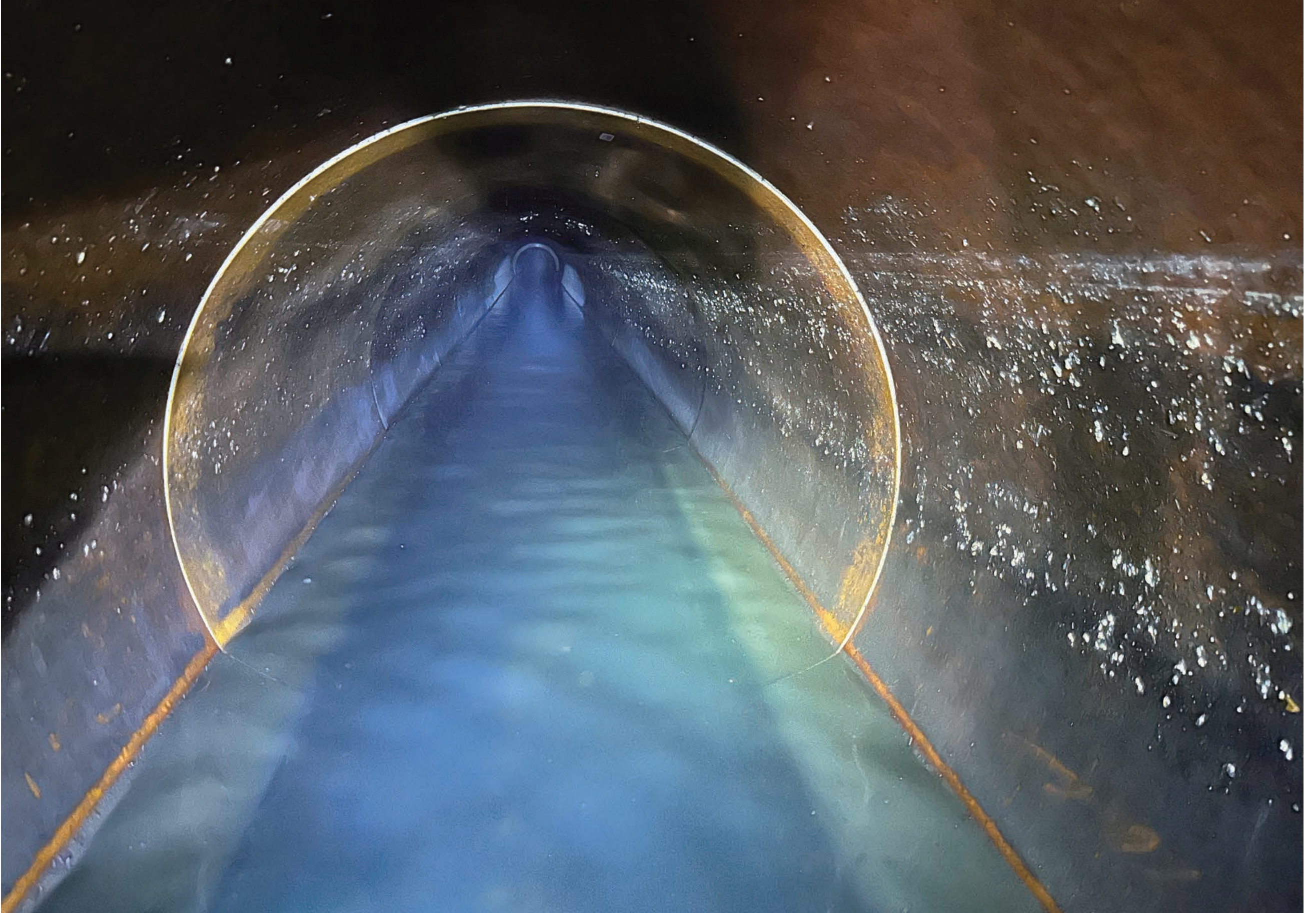
『青の洞窟』 下水道の管内を撮影したところ水面が青く輝き、幻想的でした。(千代田区外神田) 正和興業(株) 足立 政夫
