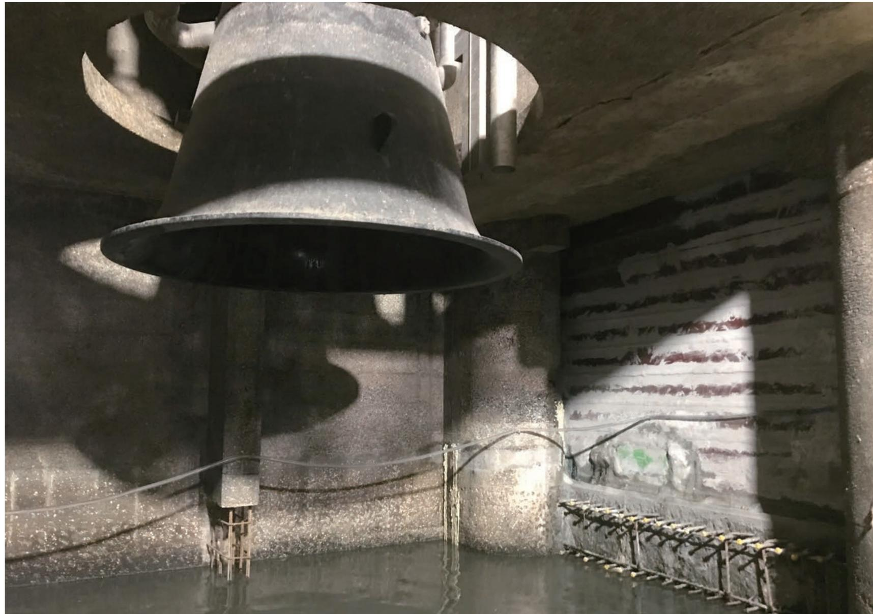
『釣り鐘発見!?!』 通常は水面下に沈む巨大ポンプの吸い込み口が、メンテに伴う排水時などに姿を覗かせます。(三河島水再生センター 藍染ポンプ所)
